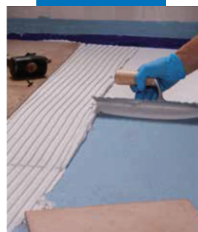
Приклеивание плитки на Mapelastic AquaDefense
