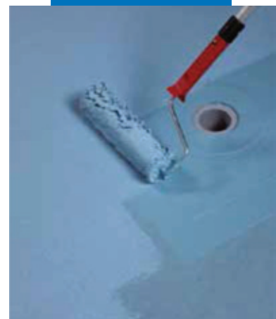
Нанесение валиком второго слоя Mapelastic AquaDefense
