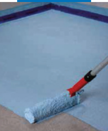
Нанесение первого слоя Mapelastic AquaDefense на стяжку
