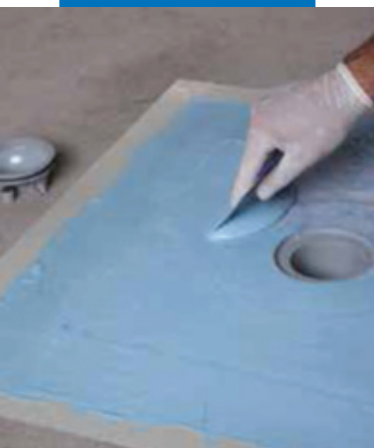
Пропитка ткани Drain Vertical составом Mapelastic AquaDefense
