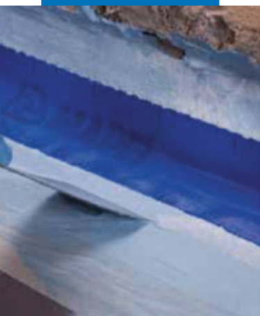
Укладка Mapeband на стык между полом и стеной с помощью Mapelastic AquaDefense
