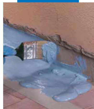
Нанесение Mapelastic AquaDefense кистью на стык между полом и стеной перед укладкой Mapiband
