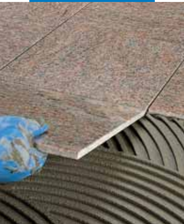
Облицовка полов полированным мрамором
