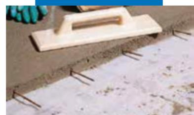
Пример стяжки Торсет с арматурными стержнями
