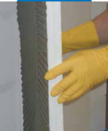
Монтаж теплоизоляционной панели
