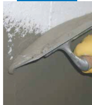
Нанесение базового штукатурного слоя
