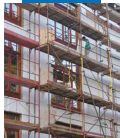
Монтаж системы утепления на фасаде здания
