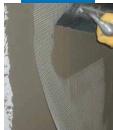
Армирование базового штукатурного слоя
