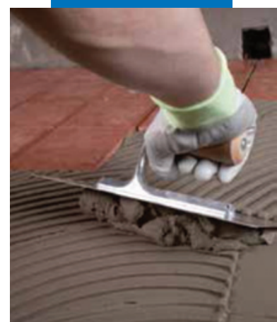
Нанесение Granirapid на гидроизоляцию Mapelastic на террасе
