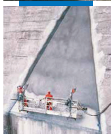
Нанесение Mapelastick на дамбу распылением
