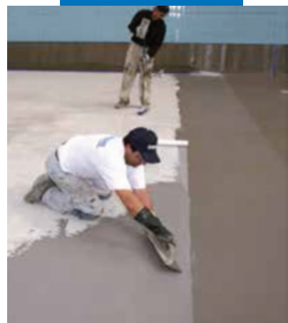
Гидроизоляция бассейна с применением Mapelastic
