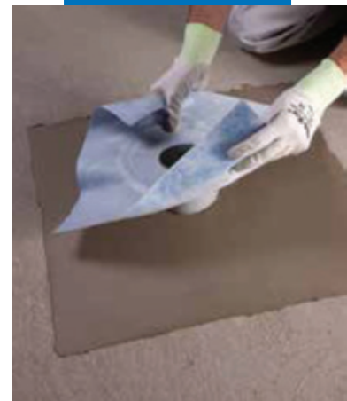
Установка вертикального дренажа на Mapelastic
