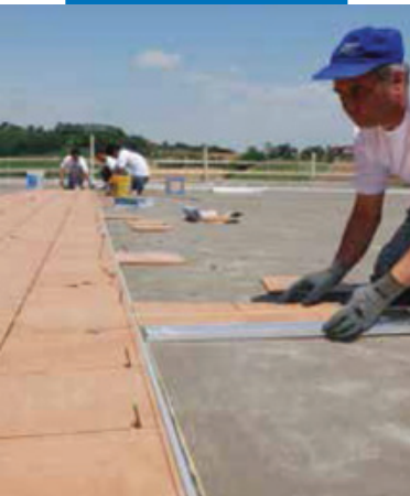
Укладка керамической плитки с применением Kerabond + Isolastic
