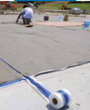
Гидроизоляция стяжки с применением Mapelastic и Mapeband
