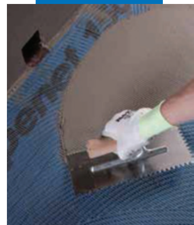
Нанесение Mapelastic на Marenet 150
